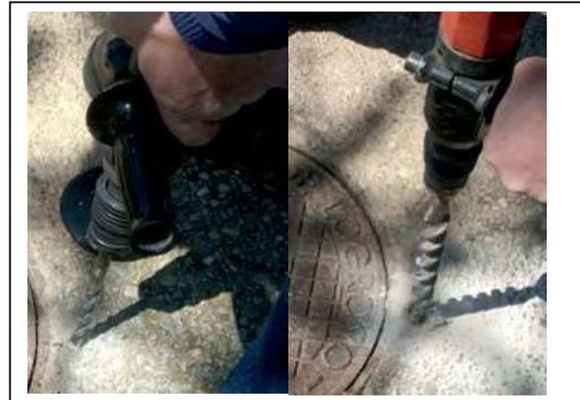
4. Percer avec un foret en 12mm sur 100mm de profondeur. Puis élargir le trou avec un foret de 25mm pour le béton.
