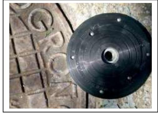
8. Placer le joint néoprène et, par-dessus, la rondelle Polypropylène ou inox juste par-dessus, dans l'alignement du trou. Noter que la cheville est composée d'une tige filetée soudée à une douille qui permet une insertion jusqu'à 25mm.
