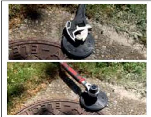
11. Pour serrer, il est possible d'utiliser une clef ou une clef dynamométrique. Il est recommandé un couple de serrage de 30Nm.
