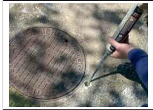
6. Remplir le trou avec du scellement chimique ou ciment pour les ancrés
