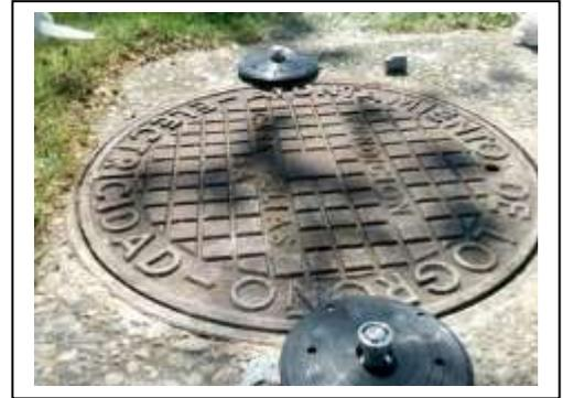
10. Une fois la vis coupée, aligner la rondelle sur la cheville insérée, insérer la vis et serrer avec la clef spécifique.
