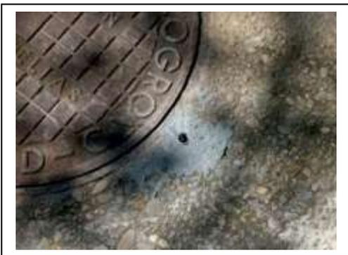
7. Insérer la cheville Fundilock de 12mm de large x 80mm de long dans le trou et presser pour qu'il soit aligné sur le niveau du tampon et scellé.
