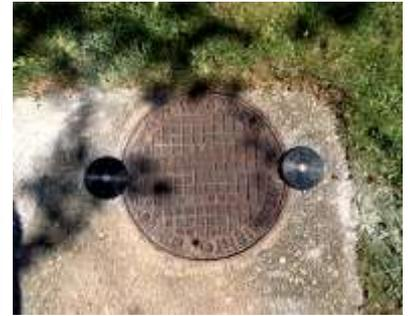
Le système antivol FUNDILOCK®, breveté, est simple et efficace : c'est une rondelle fabriquée en 3 qualités (matériaux) et deux niveaux de sécurité.
