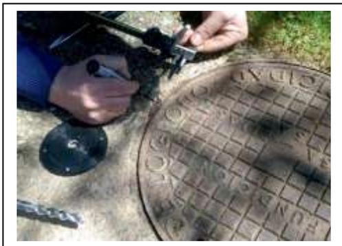
3. Chercher la zone la plus plane autour du tampon et marquer l'emplacement des trous de façon à couvrir le cadre et bloquer le maximum de surface du tampon. Ici, la vis est placée à 50mm du point à protéger.
